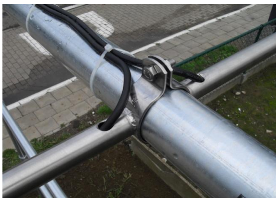
Detail kabel door inox armsteun met klembeugel
